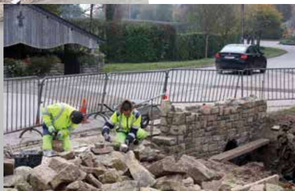
Restauration du muret face au lavoir
