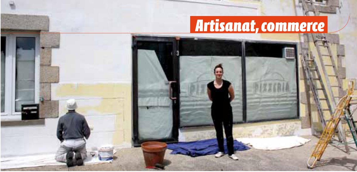
Philomène Le Hérítte lors des travaux
