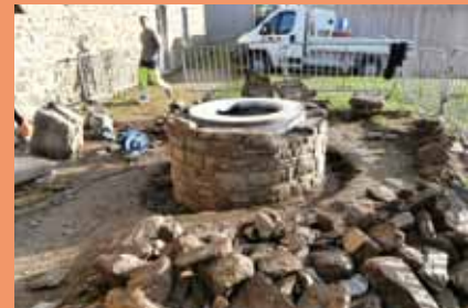
Rénovation du puits de la Longère
