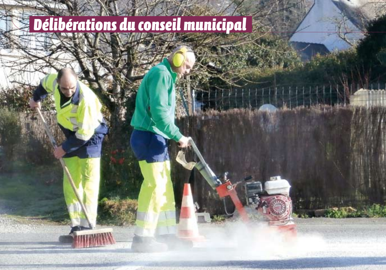
Travaux sur voirie
