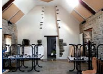
Remise en peinture de La Longère
