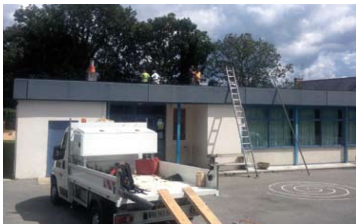
Travaux à l'école maternelle
