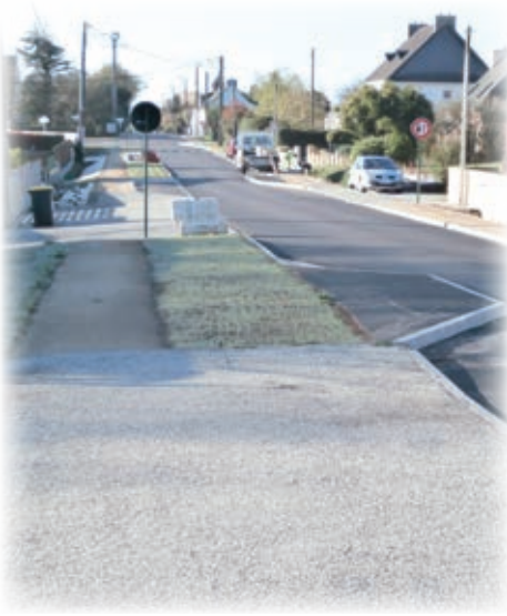
Aménagement route de Lorient
